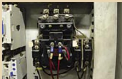
Les connexions de cette pompe d'évaporation présentent un excès de 50 degrés à la phase C.
